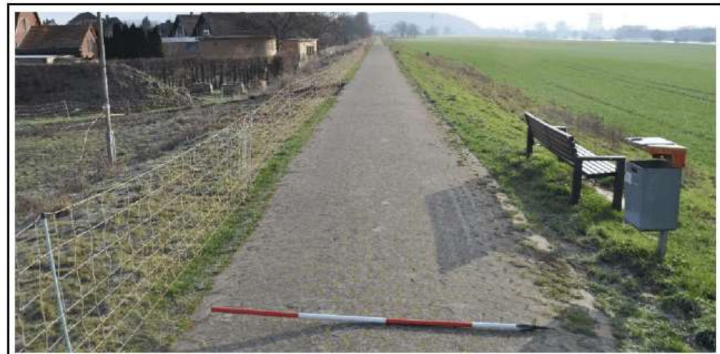
Bild 9 Station 0+313 OK Deich mit Blickrichtung stromauf Beschaffenheit: Pflasterbelag mit leichter Wölbung zur beidseitigen Entwässerung Quelle: S-L-F, 20.01.2023
