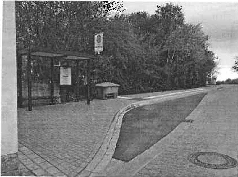
Um das Problem effizient zu lösen, wurde im Ausstiegsbereich der Wartefläche der Bord auf 4 m Gesamtlänge um 2 cm geschnitten. Somit hat der Busbord in diesem Bereich eine Ansichtshöhe von 16 cm. Diese 16 cm erfüllen dennoch den Status „barrierefrei“. Aufgrund der daraus resultierenden höheren Reststufenhöhe ist zwar eine größere Erschwernis beim Ausstieg zu verzeichnen, dennoch ist abschließend eine wesentliche Verbesserung des Haltestellenbereiches festzustellen.
